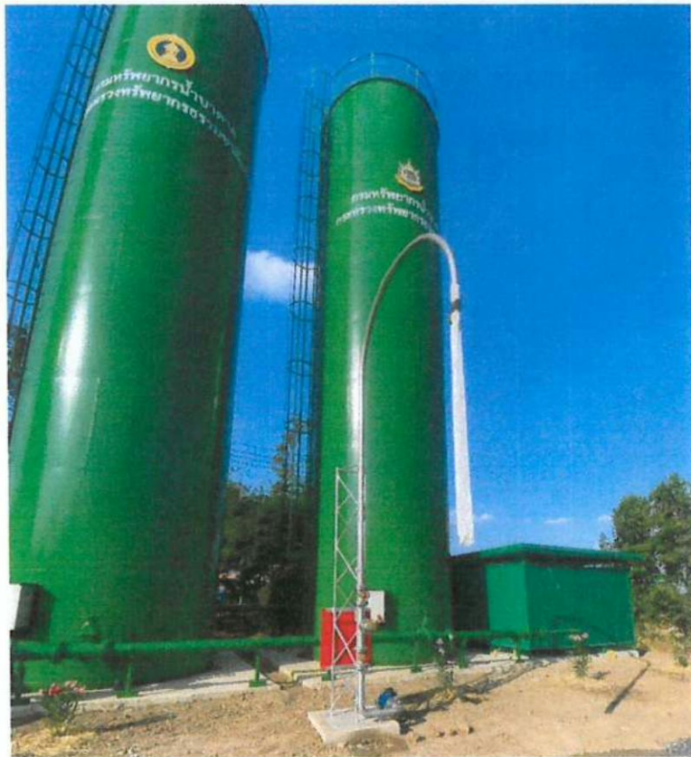
ถังเหล็กเก็บน้ำ หอถังเหล็กเก็บน้ำพร้อมทั้งจุดจ่ายน้ำถาวร (วงช้าง)
